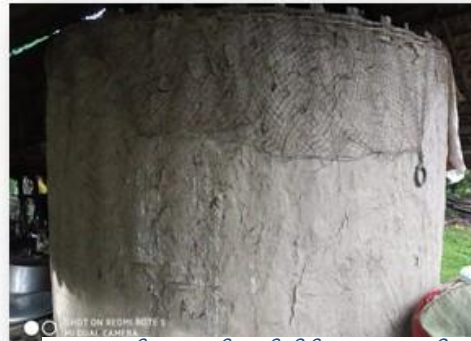
နွားချေးနှင့်ရွှံ့ ရော၍သုတ်လိမ်းထားသော ဝါးကျို
